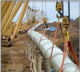
Verlegung der Rohre
