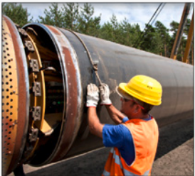
Zusammenführen der Rohre
