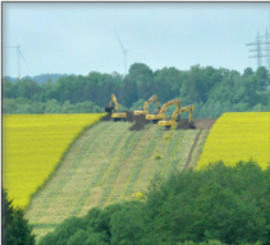
Mutterbodenabtrag
