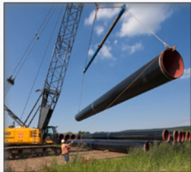
Anlieferung der Rohre
