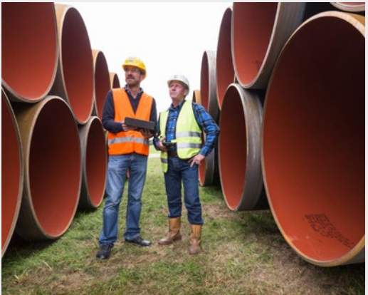
Große Rohre für viel Energie. Jedes Rohr hat einen Durchmesser von 1,40 Meter, ist rund 18 Meter lang und wiegt 15 Tonnen.
