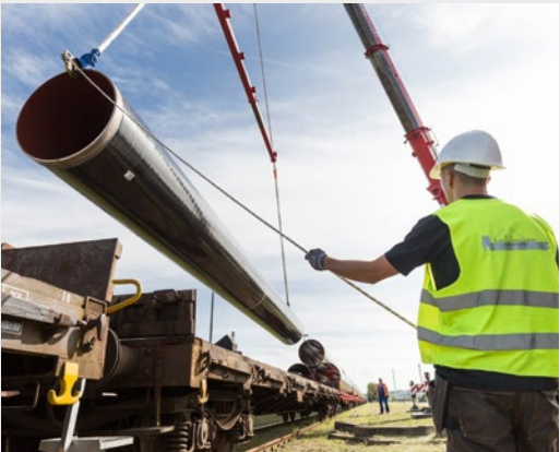
Die Bahn bringt die EUGAL-Rohre an ausgewählte Bahnhöfe. Gefertigt werden die Rohre in Deutschland von EUROPIPE in Mülheim an der Ruhr.
