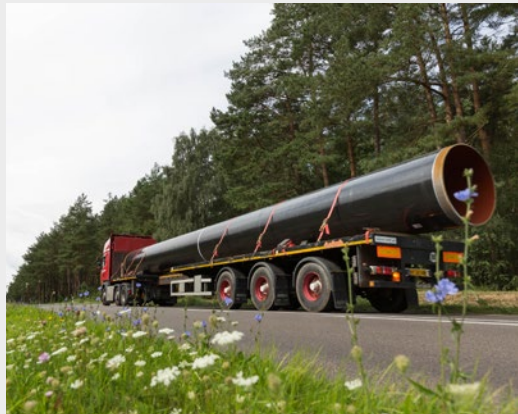
Rohrausfuhr: Ein LKW bringt ein EUGAL-Rohr von einem Bahnhof zu einem nahegelegenen Rohrlagerplatz.
